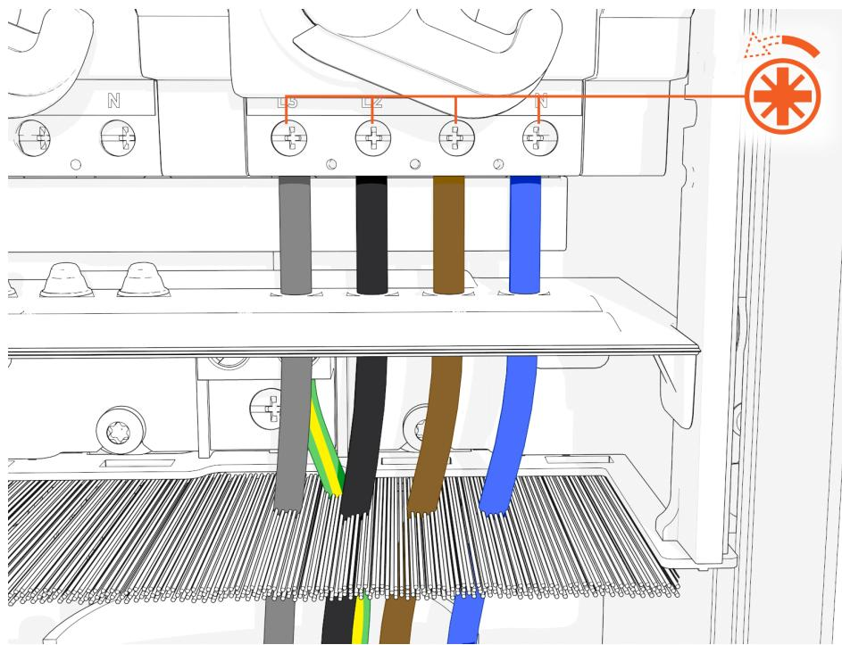
2. Lösen Sie mit einem T25-Drehmomentschraubendreher die Schrauben, mit denen die Stromversorgungsplatte befestigt ist, aber entfernen Sie sie nicht.
