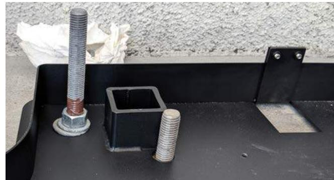
13. Utilisez un niveau pour vérifier que chaque boulon d'ancrage est d'aplomb et ajustez-les pendant que l'époxy permet encore de le faire.
