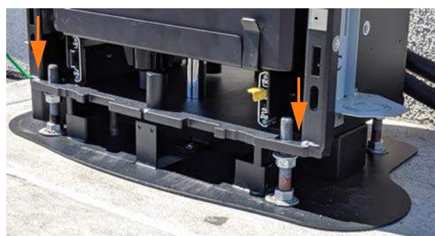
6. Placez les rondelles et écrous supérieurs sur les boulons d'ancrage, au-dessus de la plaque de base de la borne Express 250, puis soulevez les écrous de mise à niveau contre la plaque de base, conformément au *Guide d'installation de la borne Express 250*.
