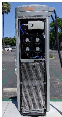
15. Tous les panneaux de protection de la borne sont remplacés et toutes les attaches des panneaux de protection sont correctement serrées (extrusions, panneau arrière supérieur et barre lumineuse de la zone).
