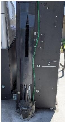
11. Les unités Power Module sont installées et le mécanisme recouvre entièrement les ailettes en plastique des unités Power Module des deux côtés, sans écart :
