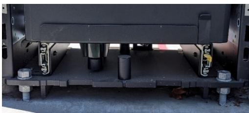
Boulons d'ancrage de la borne, arrière :
