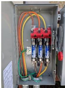
Photo de l'intérieur de l'interrupteur sectionneur CA :
