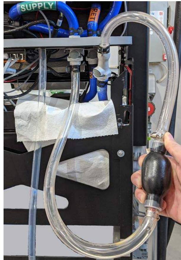
12. Attachez la conduite de liquide de refroidissement la plus à l'arrière à la conduite de liquide de refroidissement de retour (j) pour relever son angle et empêcher l'air de s'accumuler dans la conduite.
