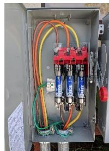
Bild vom Inneren des AC-Trennschalters:
