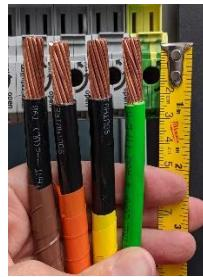
5. An den Anschlüssen der AC-Klemmleiste liegen weder Kupferkabel frei, noch sind sie abgeschnitten. Alle Litzen sind eng gebündelt und wurden durch leichtes Ziehen und Drücken geprüft.
