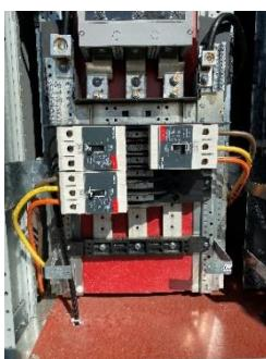
9. Schalttafel, vordere Sperrabdeckung montiert und Nennwerte der Leistungsschalter sichtbar:
