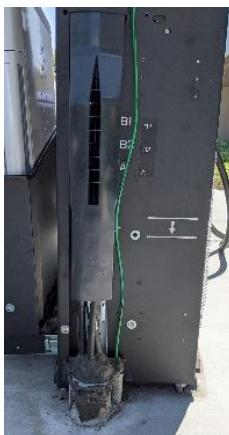
11. Die Powermodule wurden installiert, und der Mechanismus deckt die Kunststofflamellen auf beiden Seiten des Powermoduls vollständig ab, es sind keine Lücken vorhanden:
