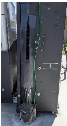
11. I Power Module sono installati e il meccanismo copre completamente le alette in plastica del Power Module su entrambi i lati, senza spazi:
