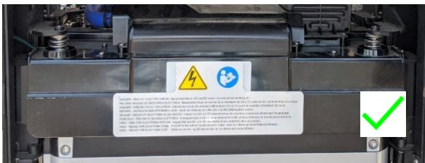
12. Il serbatoio del refrigerante è pieno e l'installatore ha eseguito una prova di trazione-spinta su entrambi i collegamenti rapidi:
