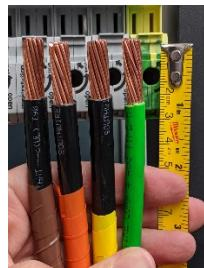
5. Nessun filo di rame è esposto o tagliato in corrispondenza dei collegamenti della morsettiera CA. Tutti i trefoli sono ben fissati e sono stati testati con una prova di trazione-spinta.
