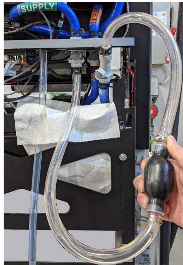
12. Fissare la tubazione del liquido di raffreddamento più arretrata alla tubazione del liquido di raffreddamento di ritorno (j) per aumentarne l'angolazione e impedire l'accumulo di aria nella tubazione.
