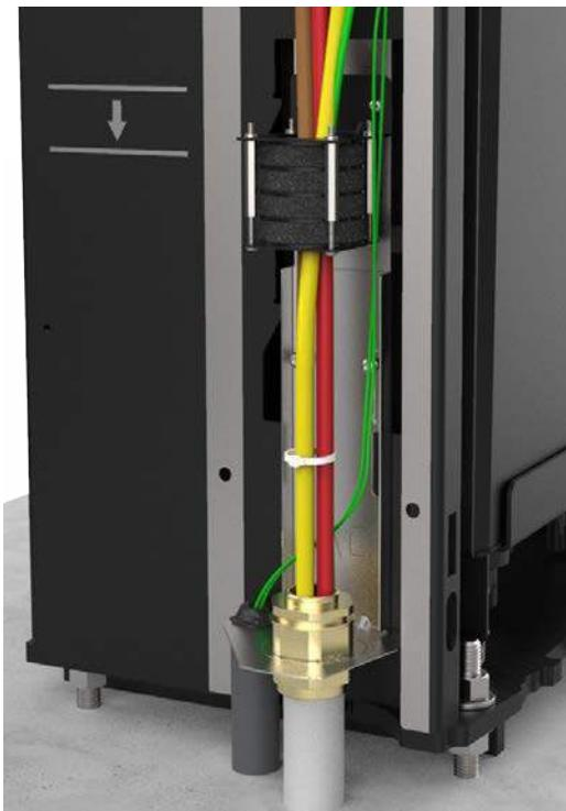
15. Utiliza sujetacables para fijar los cables de CA y de conexión a tierra en uno o dos lugares.
