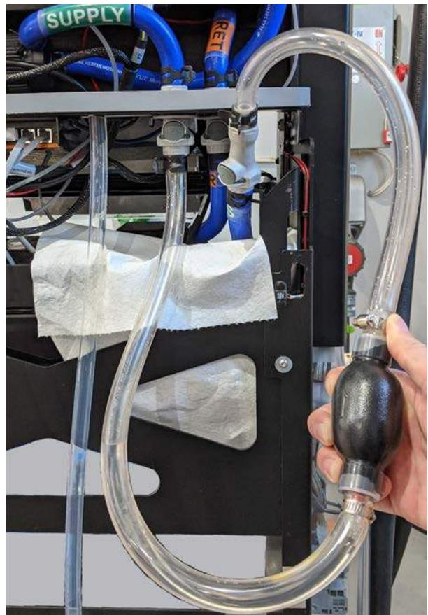
12. Sujeta la línea de retorno del refrigerante (j) con una brida para colocarla en un ángulo más elevado y evitar que se introduzca aire.
